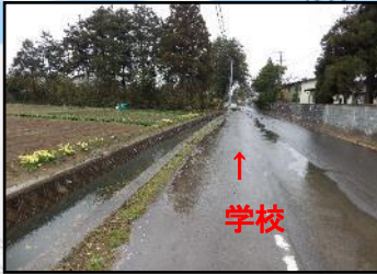
ガードレールがない
