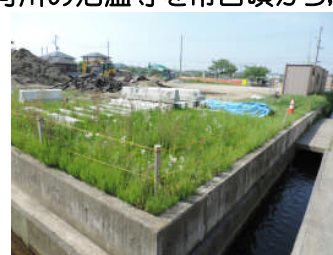
〈学校周辺の水路と工事現場〉
