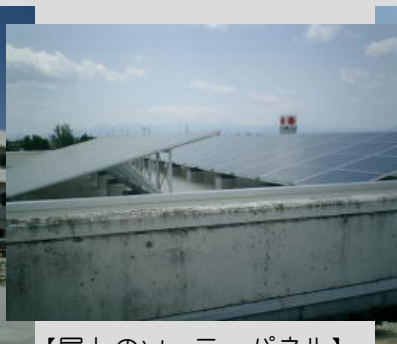
【屋上のソーラーパネル】
